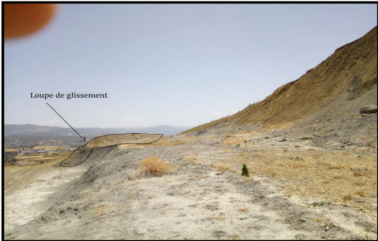
Figure V-6 : Loupe de glissement rencontré dans la partie exploitée du gisement.
