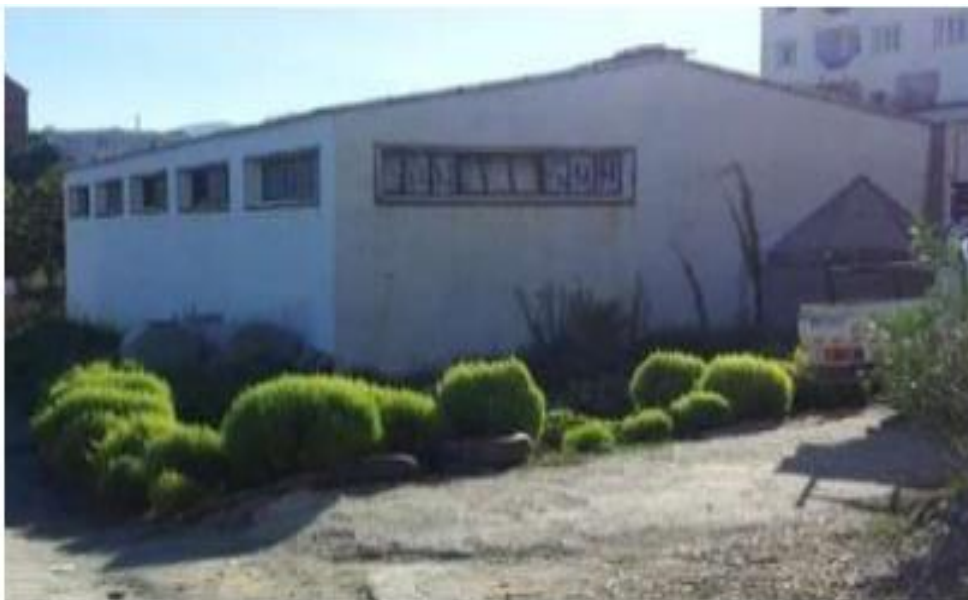
Figure 13 : Vue extérieure de la station d'élevage de Tizirt.
