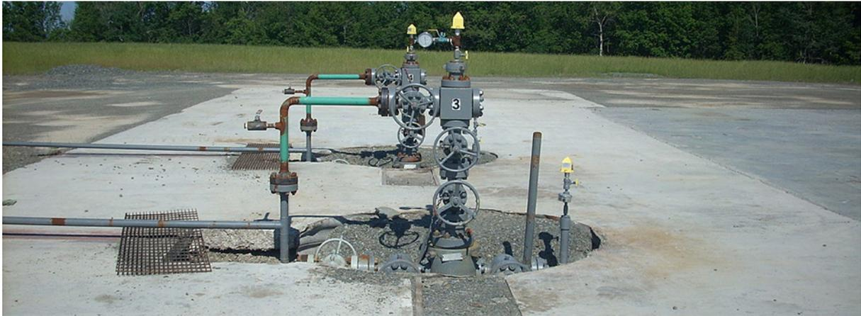
**Figure 4.3 :** Puits de gaz de schiste relié au gazoduc. [45]
