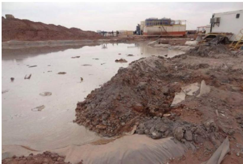
**Figure 4.7:** Bassin de décantation mal entretenu [42]
