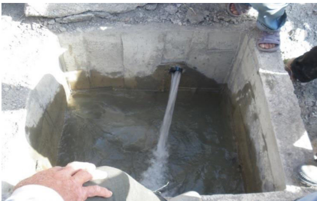
Figure 04 :Captage d'eau
