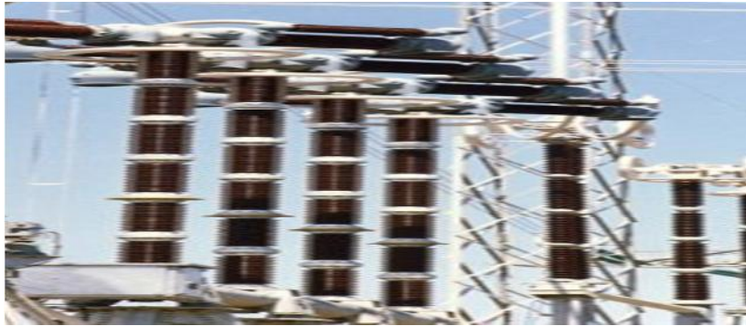
Figure II.1 disjoncteur à air comprimé.[4]
