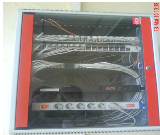
Figure I.5: L'armoire d'étage
