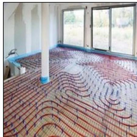
Fig.1-67 : plancher chauffant rafraîchissant
