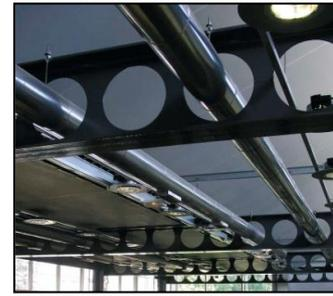
Figure 4-57 : Poutre alvéolaire
