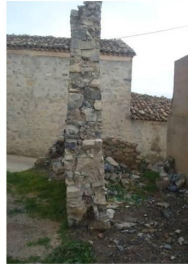
**Photo 3.5 :** Coupe verticale illustrant la différence d'épaisseur dans un mur. Ighil-Ali la Qallaa d'Aït Abbas, Bejaia. (Source : auteur).
