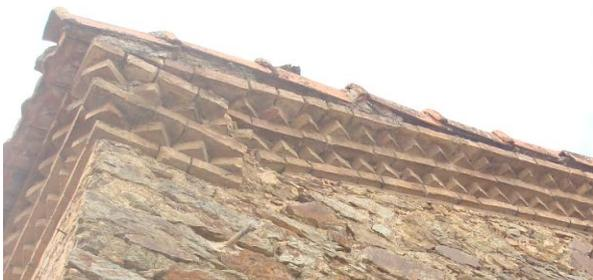
La toiture repose sur une corniche de rangées de briques en terre.
