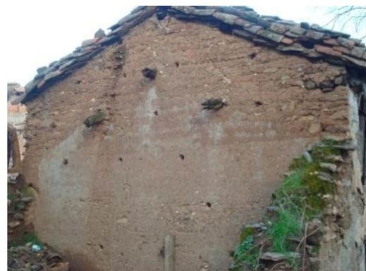
**Photo 3.30** : L'emplacement des laçonniers est très important dans le mur en pisé. Nous constatons, dans ce mur, que les trous ne sont pas tous alignés. Village Maatkas, Tizi-Ouzou. (Source : auteur).
