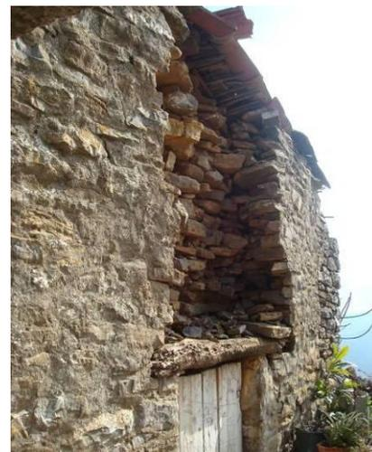
**Photos 4.22 :** Effondrement du parement extérieur des murs.
