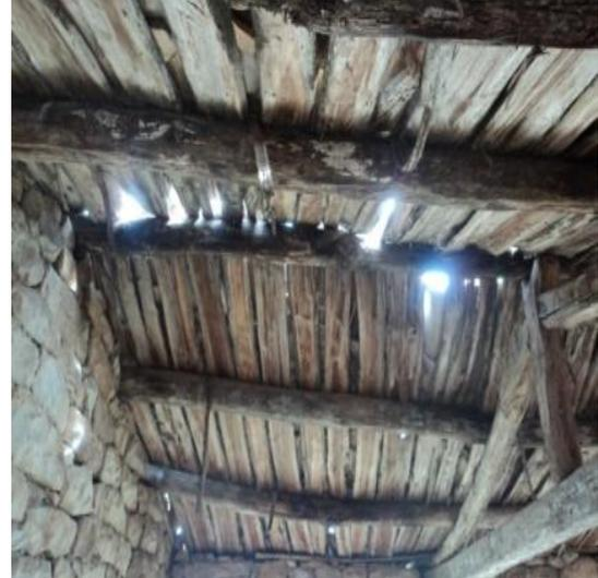
**Photo 3.57 :** Les tuiles sont posées sur un platelage. Village Imaghdacen, Bejaia. (Source : auteur)
