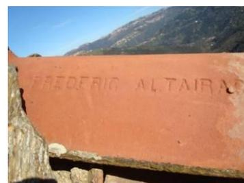
**Photo 3.42 :** Tuile mécanique en terre.
