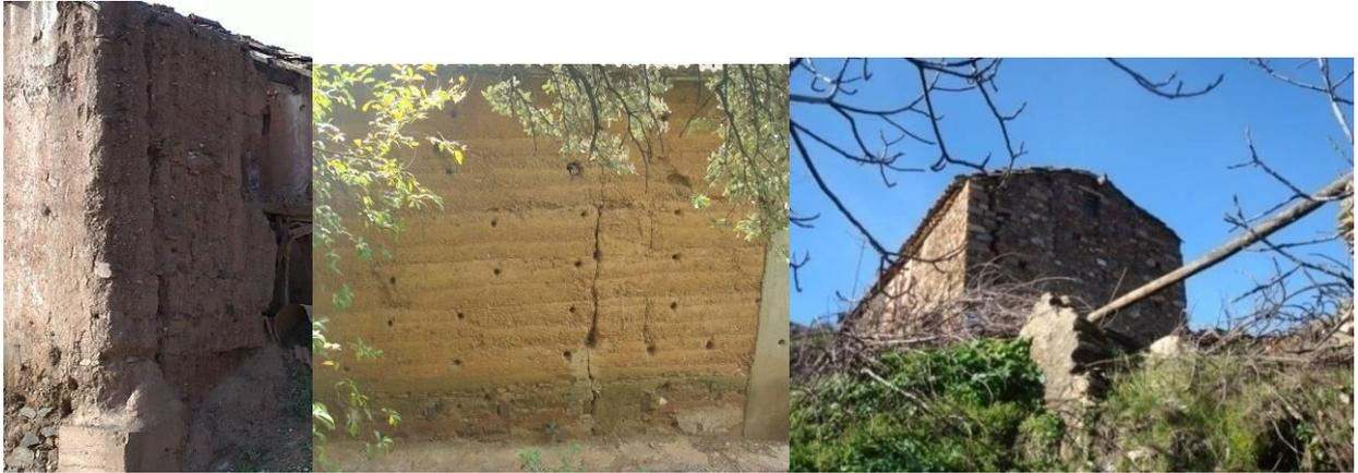
**Photos 4.17** : Fissuration sur les murs en pisé et en pierres. Village Maatkas, Tizi-Ouzou. (Source : auteur)
