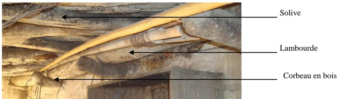
**Photo 3.37 :** Sous-plancher des appuis sur lambourdes fixées sur des corbeaux en bois. Village Maatkas, Tizi-Ouzou. (Source : auteur).
