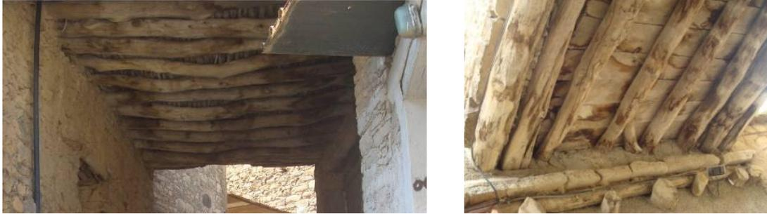
**Photos 3.35 :** Appui direct des solives sur le mur.
