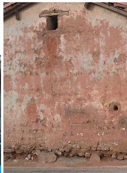
**Photo 4.5.** Remontée capillaire sur mur en pisé. Village Maatka, Tizi-Ouzou. (Source : auteur).
