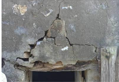
**Photos 4.23 :** Images illustrant l'état de dégradation avancée des linteaux.
