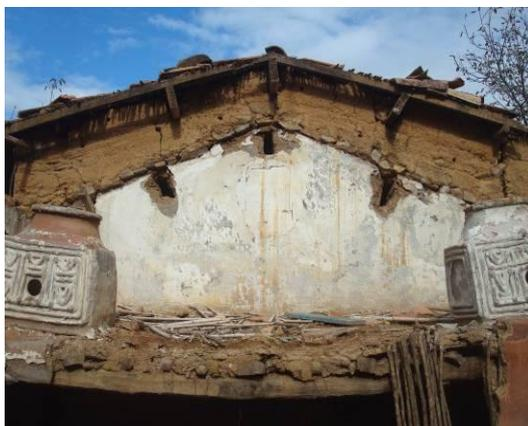
**Photo 4.24** Fléchissement des solives du plancher (*taaricht*) entraînant son effondrement. Village Maatkas, Tizi-Ouzou. (Source : auteur)
