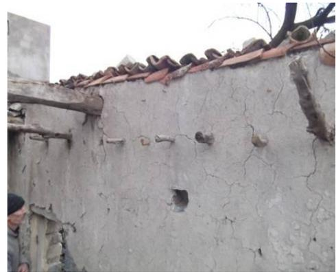
**Photo 3.62 :** Enduit de chaux additionné à du plâtre, appliqué sur les parois intérieures des maisons. (village Ighil-Ali la Qallaa d'Aït Abbas, Bejaia. Source : auteur).
