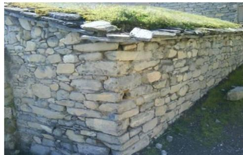
Sur ces photographies, que ce soit des couvertures en tuiles ou en terre, les toitures sont directement posées sur des pierres plates. A gauche : Village Aït Daoud, Béni-Yénni, Tizi-Ouzou. A droite : Village Boudjlil, Béjaia.
