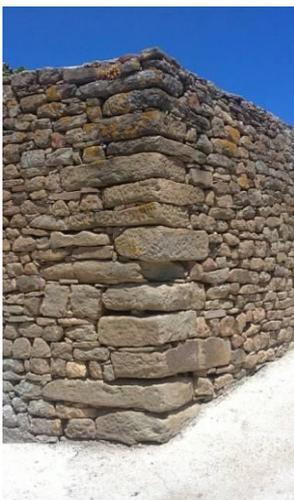
**Photo 3.20** : Forme et taille des pierres d'angle différentes de celles du courant du mur. Village d'Azefoune, Tizi-Ouzou (Source : auteur).
