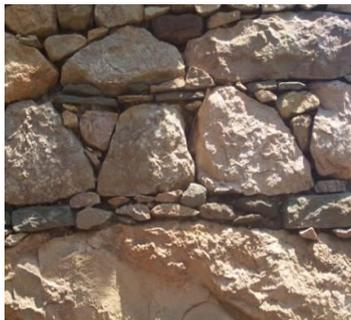
**Photos 3.11** : Moellons ébauchés avec calage, réalisé au moyen de petits cailloux ou bien de tuiles cassées. A gauche : Village Aït El Kaid, Tizi Ouzou. A droite. village Ighil-Ali la Qallaa d'Aït Abbas, Bejaia (Source : auteur).
