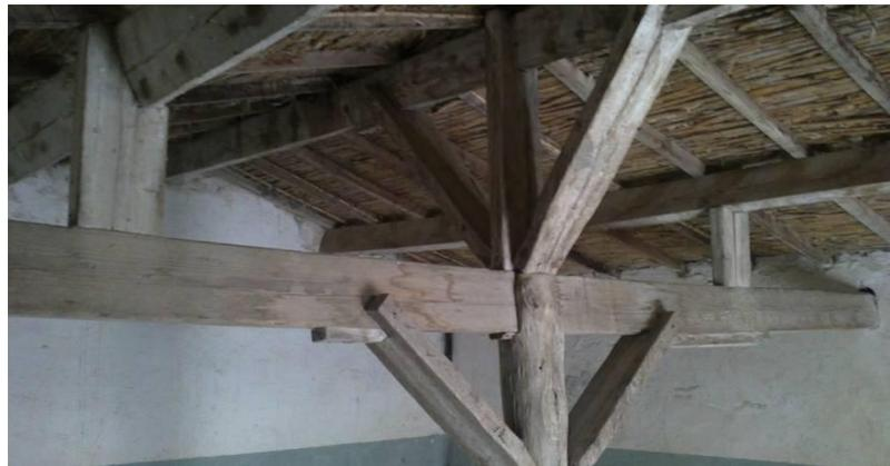
**Photo 3.50** : images montrant les éléments en bois composant la charpente d'une *tajmaat*. Village Aït Saada, Béni-Yénni, Tizi-Ouzou. (Source : auteur.)
