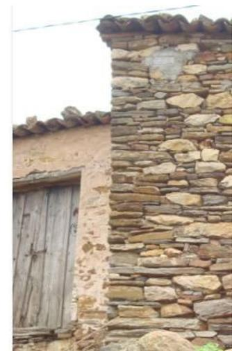
**Photo 3.21** : Forme et taille des pierres d'angle identiques à celles du courant du mur. Village Mazekwane, Bejaia. (Source : auteur).
