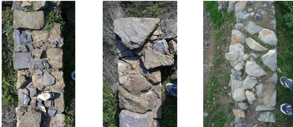
**Photos 3.8 :** Coupes transversales illustrant le positionnement des pierres.
