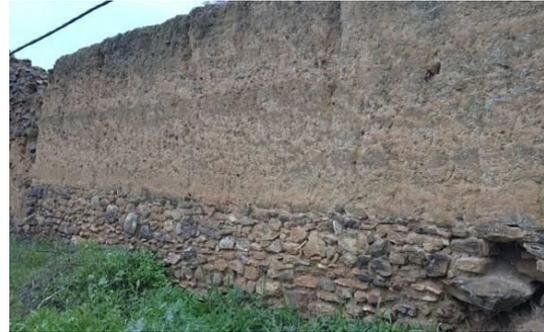
**Photo 3.26 :** Mur en pisé avec soubassement.
