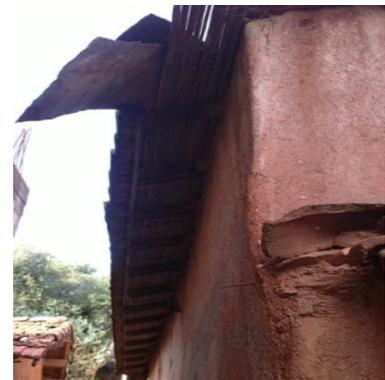
La toiture est posée directement sur le mur.
