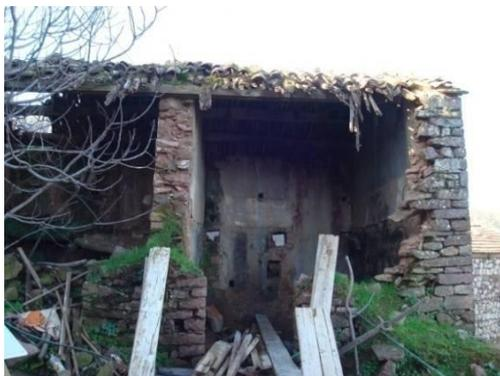
**Photo 3.23 :** Jonction entre mur de refend et mur de façade. (Source : auteur).
