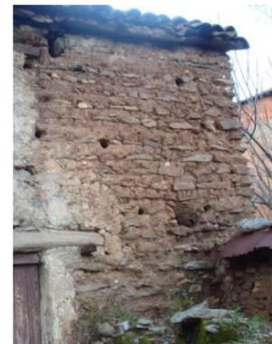
**Photo 3.28 :** Ces deux murs ne sont pas totalement en terre ou en pierre. Il existe une alternance entre les deux matériaux. Cette alternance forme des séparations presque égales entre la strate de pierres et la strate de terre. Village Ath Yenni, Tizi-Ouzou (Source : auteur).
