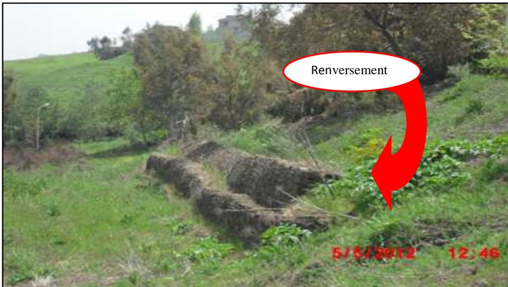
*Figure III.8 : Renversement du gabionnage.*
