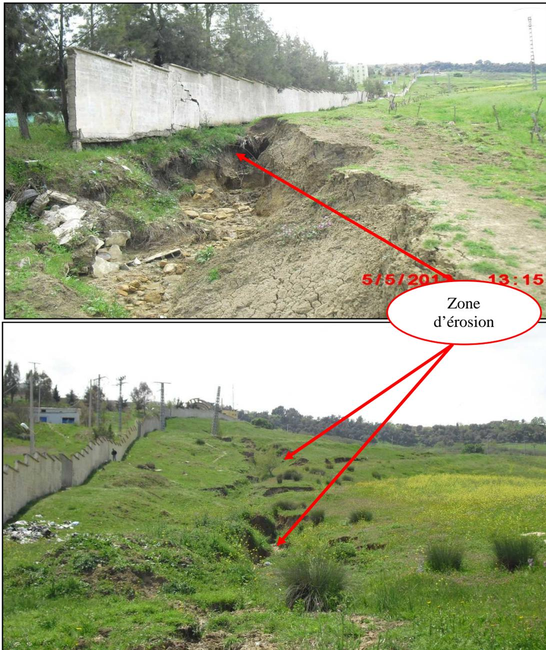
Figure III.14 et 15: Erosion du sol (due à l'éclatement de réseau d'assainissement).
