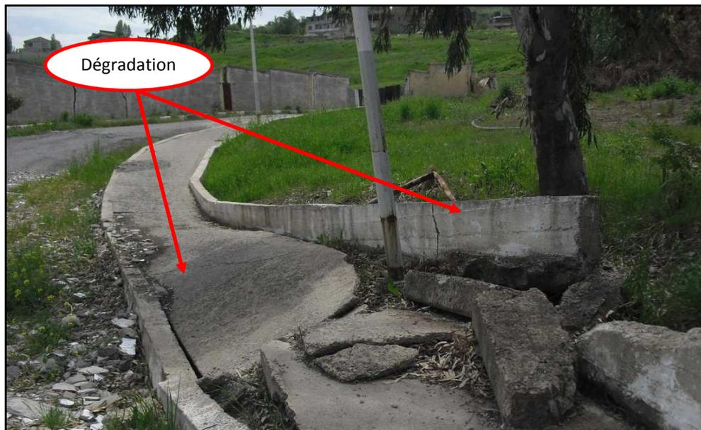
*Figure III.9: Dégradation du trottoir intérieur de la cité.*
