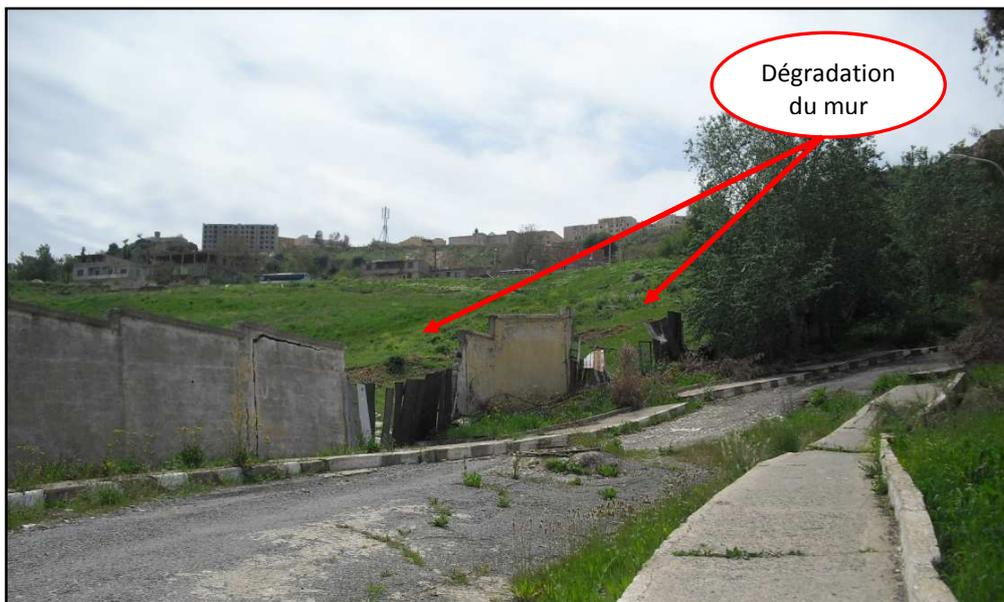
*Figure III.11: Dégradation avec déplacement de la clôture extérieure de la cité.*
