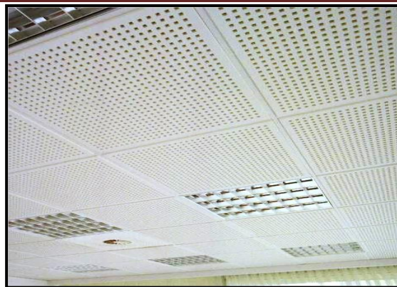
Fig 140: Plafond en plâtre
