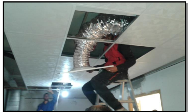
Fig133: faux plafond en plaque de plâtre
