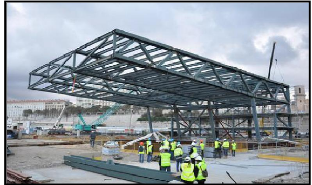
Fig 129: la structure de port à faux de la villa méditerranéenne Source : http://www.villa-mediterranee.org
