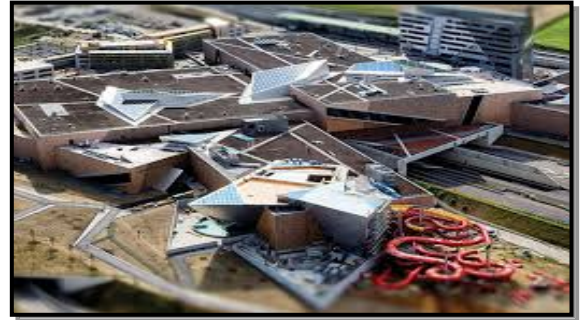
Fig76: Vue sur l'ensemble du projet Source : Wikipédia.
