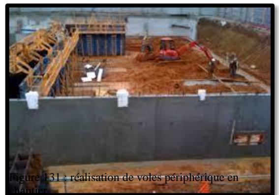
Figure 131 : réalisation de voles périphérique en chantier
