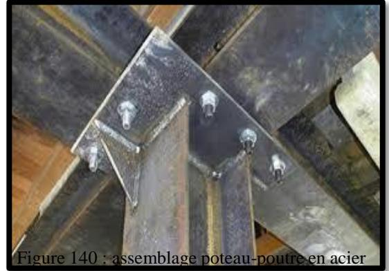
Figure 140 : assemblage poteau-poutre en acier
