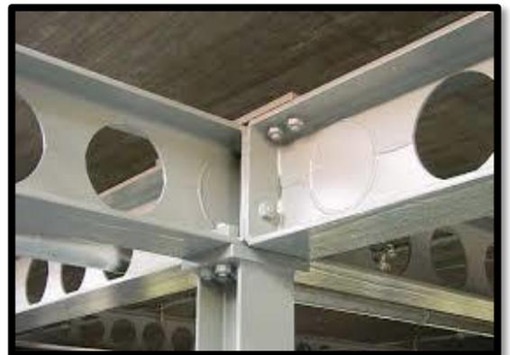
Figure 136 : les poutres alvéolaires
