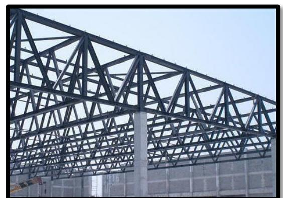
Figure 139 : assemblage poteau en béton-poutre métallique
