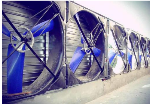
Figure I. 6: L'installation des ventilateurs muraux.
