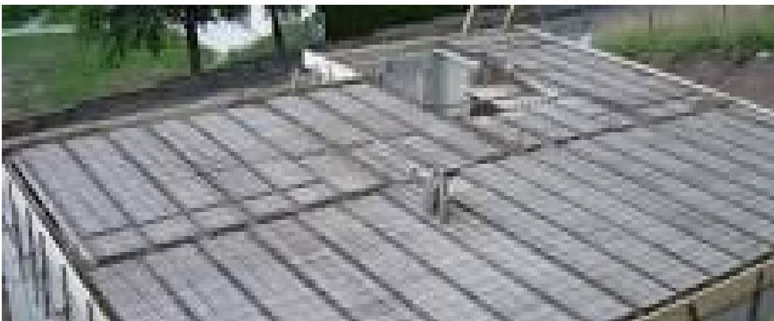
**Figure I.1: plancher en corps creux.**
