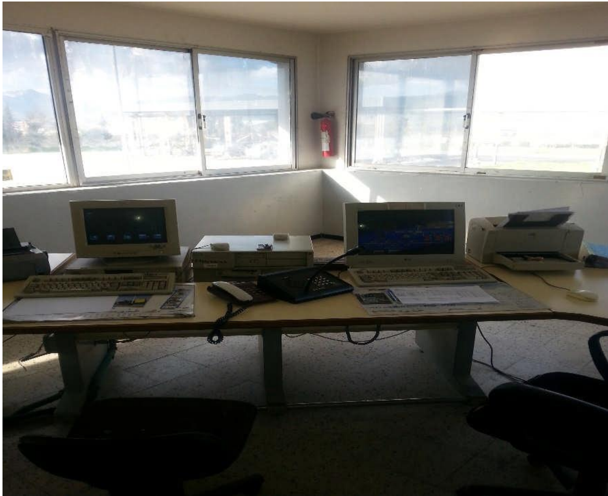
Figure I.6 : poste de supervision.
