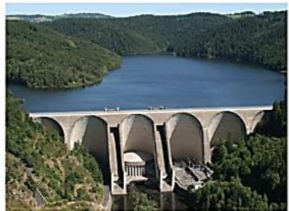
Figure I.3 : Barrage à contreforts
