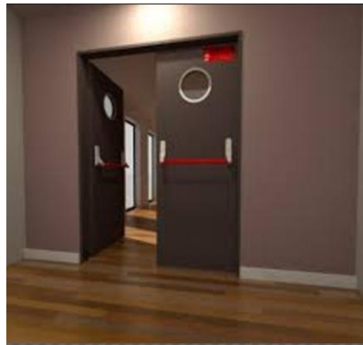
Figure188 : Exemple porte coup feux. Source :
