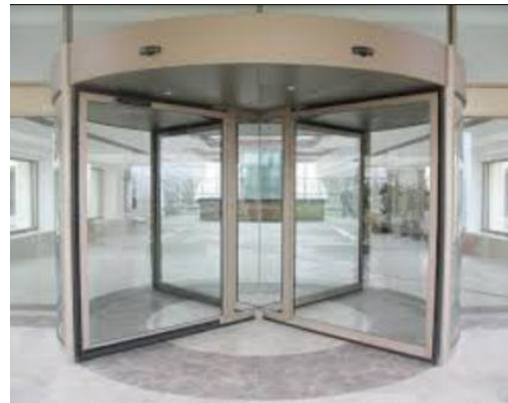
Figure 187 : Exemple de porte tambour.
