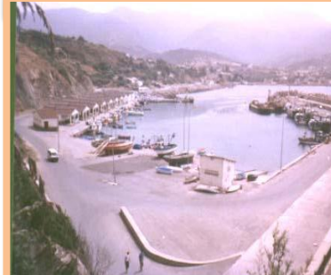
Edification du port du Gueydon
