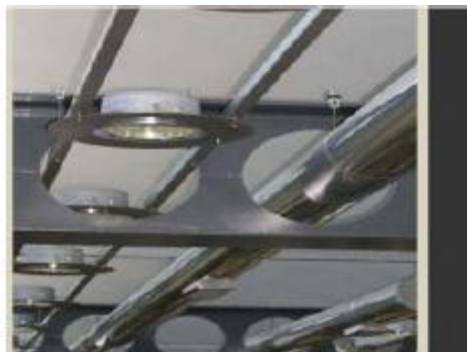
Figure 164: Détail de poutre alvéolaire.
