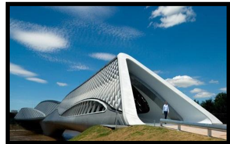
Figure 95: Pavillon pont de Saragosse de Zaha Hadid. Source : http://nttw.co/zaha-hadid/
