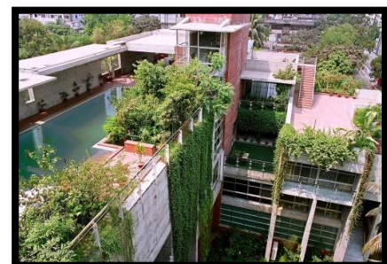
Figure 97: Toit-terrasse d'un penthouse appartement au Bangladesh. Source : https://fr.wikipedia.org
