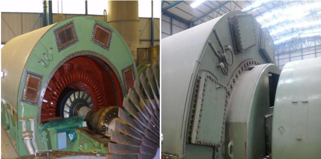
**Figure IV-3 :** Disposition des réfrigérants le long de l'enveloppe du stator
