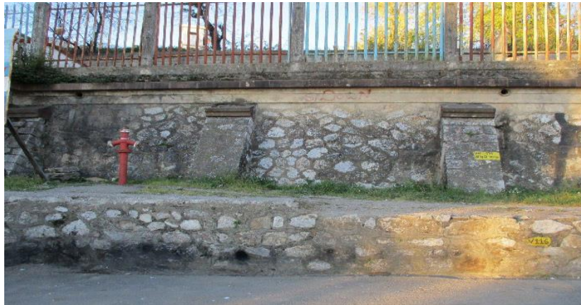
Figure 1.19 : Murs extérieurs et Contrefort (Houamdi et Moukah).
