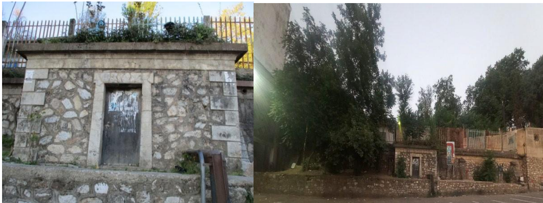
Figure 1.1 : Vue de face du réservoir en maçonnerie de LNI (Houamdi et Moukah, 2023).
