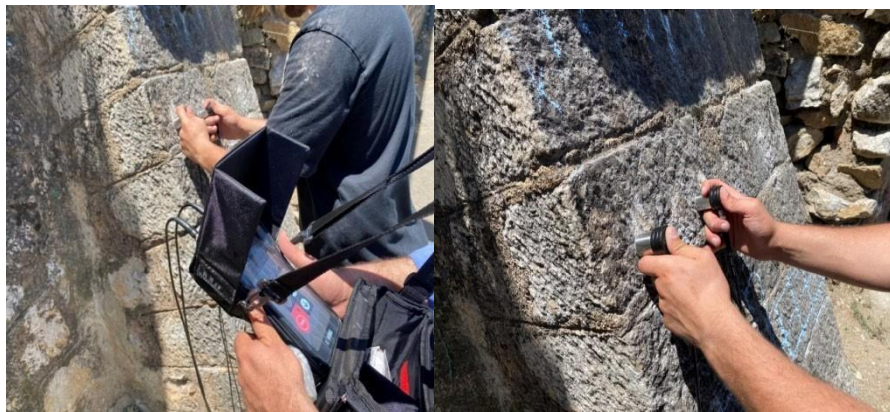
Figure 1.6 : Essai ultrason (mesure en surface) (Houamdi et Moukah, 2023).
