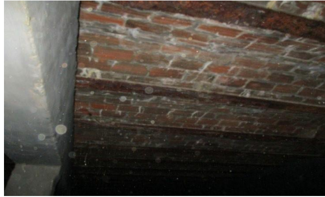
Figure1.16 : Dalle en maçonnerie (Houamdi et Moukah).
