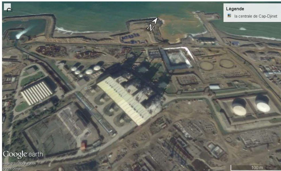
Figure I.1 : Vue de la centrale de Cap-Djinet par satellite.
