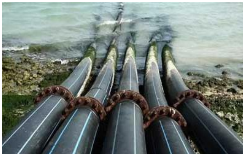
Figure I.9 : Emissaires de prise d'eau de mer [17].
