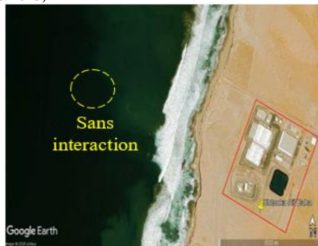
Figure II.5 : Image satellite de la station de dessalement Chtouka Ait Baha [31], [50].
