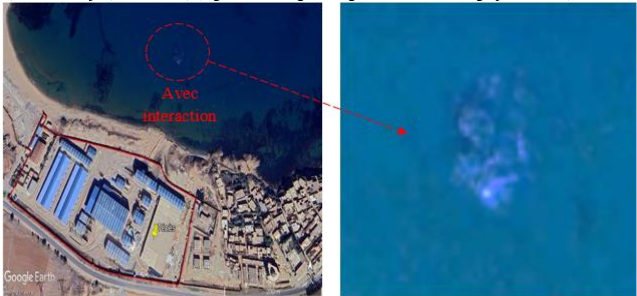
Figure II.4 : Image satellite de la station de dessalement Ténès [31], [50].
