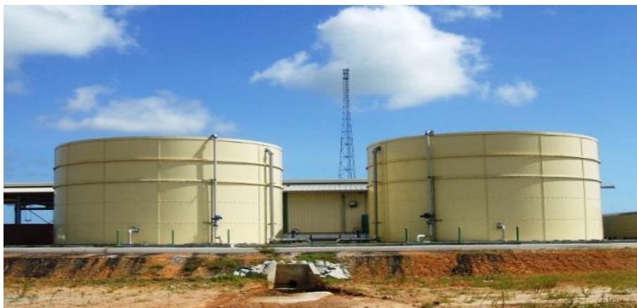
Figure I.14 : Back de stockage d'eau dessalée [21].
