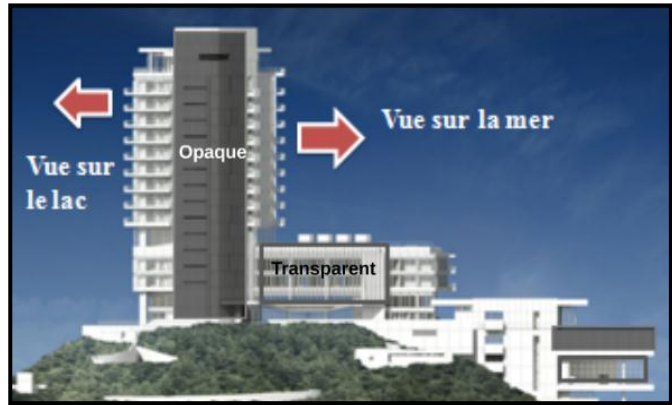
Figure 113 : façade ouest de l'hôtel.
