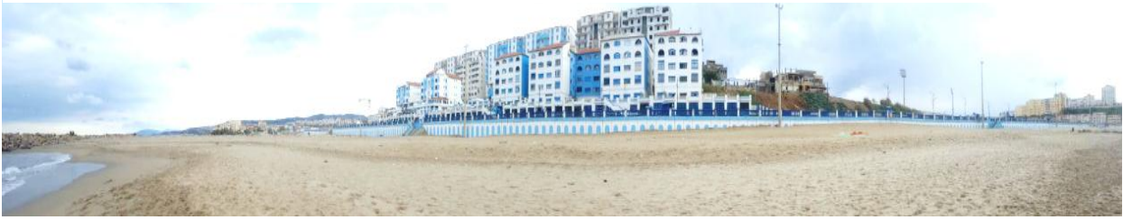
Figure 52 : la façade maritime Source : auteurs
