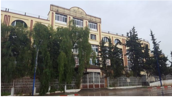
Figure 29 : Hôtel Soumam Source : Auteurs
