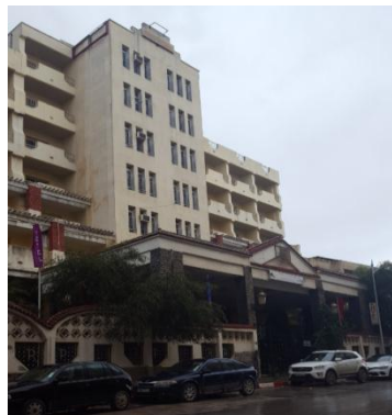
Figure 27: Hôtel Le Rocher Source : Auteurs
