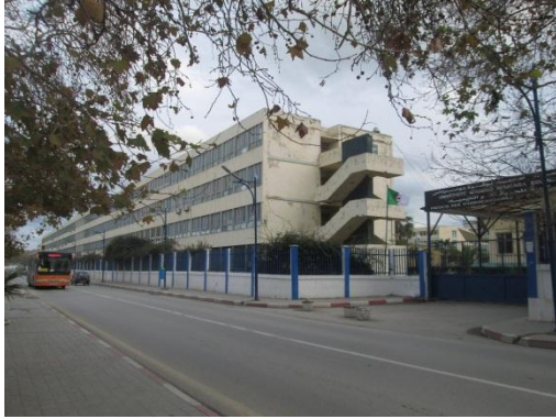
Figure 21 : faculté des hydrocarbures et de la chimie Source : Auteurs
