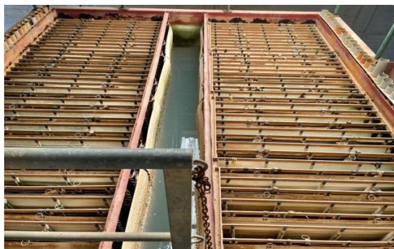
Figure III.6 : Séparateur lamellaire.
