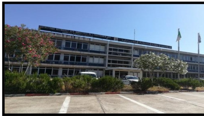
Figure III.1 : Complexe d'appareils ménagers de l'ENIEM.
