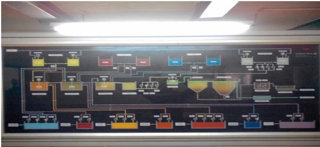
Figure III.2 : Schéma de la station de neutralisation de la CAM.
