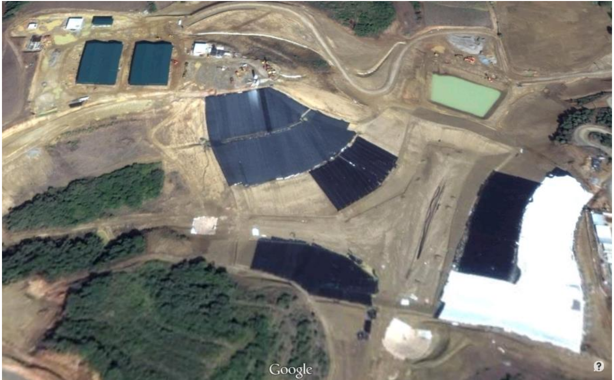
Figure I.2 : Vue d'ensembles de C.E.T Corso.
