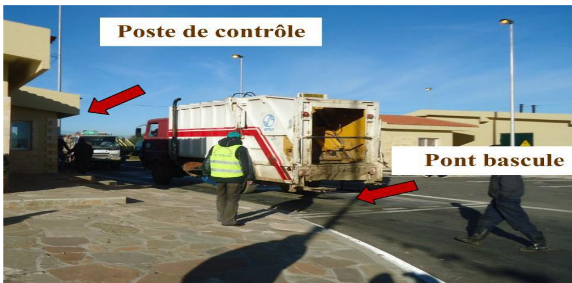
Figure I.3 : Poste de contrôle et pont-basculé
