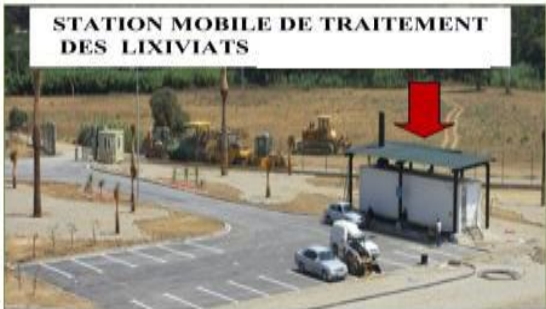
Figure I.12 : Station mobile de traitement des lixiviats
