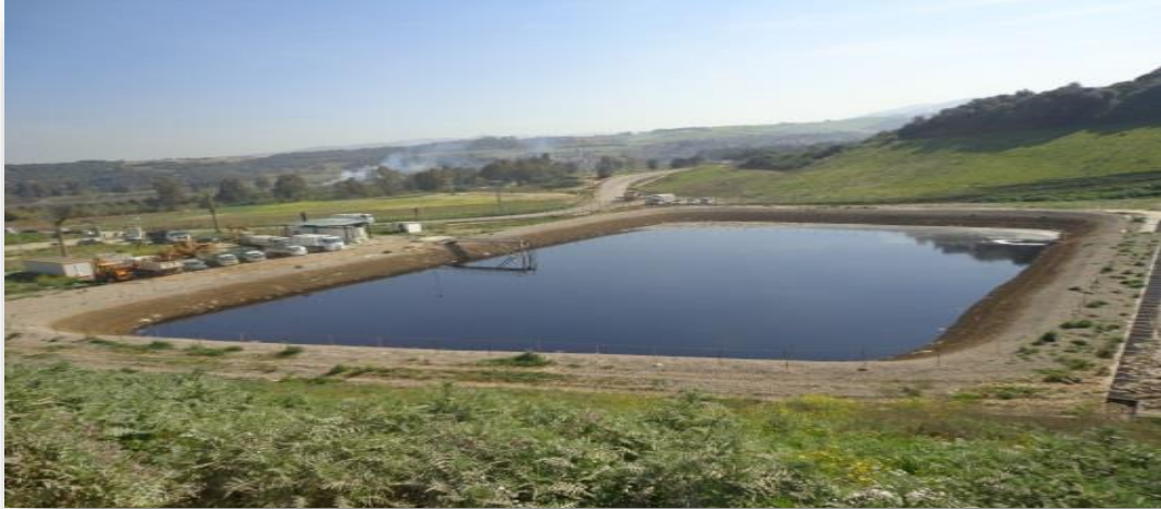
Figure I.11 : Bassin de stockage des lixiviats du C.E.T de corso
