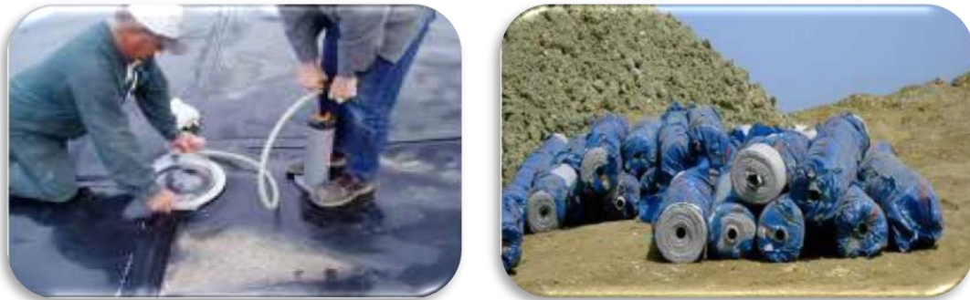
Figure I.8 : Mise et soudure de la géo membrane et de la Géotextile.
