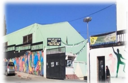
Photo14: Gaffitis sur la paroi Source : Auteurs.
