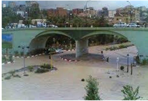
Photo 35: Inondation du boulevard Krim Belkacem.
