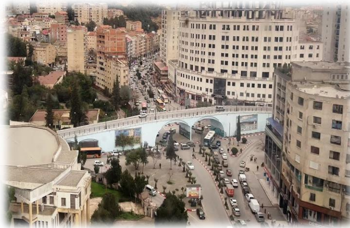
Photo 16: Pont du carrefour 20Avril
