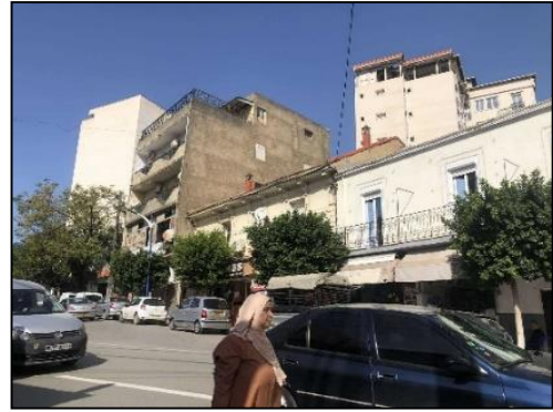
Figure 112: La vue sur la façade droite de la rue Mazira Md Arezki, source: Auteurs, 2024
