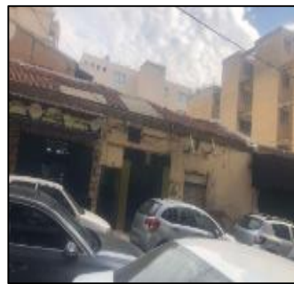
Figure 257: Les bâtisses coloniales avant la requalification
