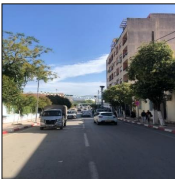
Figure 41: vue sur la façade gauche de 1er tronçon boulevard houari Boumediene , source les auteurs 2024.
