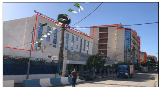
Figure 149: Vue sur la façade nord de la 3ème entité, source: auteurs 2024
