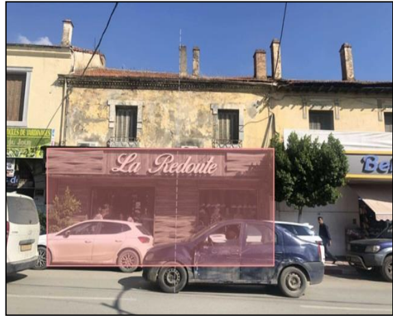
Figure 134: Vue sur une bâtisse coloniale de le bd Houari.B, source: auteurs,2024
