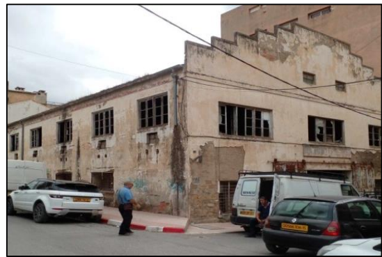
Figure 159: vue en perspective du dépôt, source: auteurs 2024
