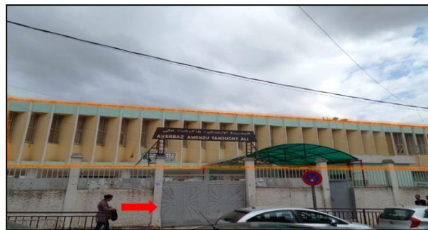
Figure 164: Vue sur la façade principale de l'école Takoucht Ali, Source: auteurs 2024
