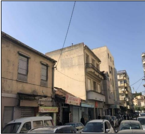
Figure 81: Vue en perspective sur la façade gauche de la rue Oubouzar Cherif, source les auteurs 2024
