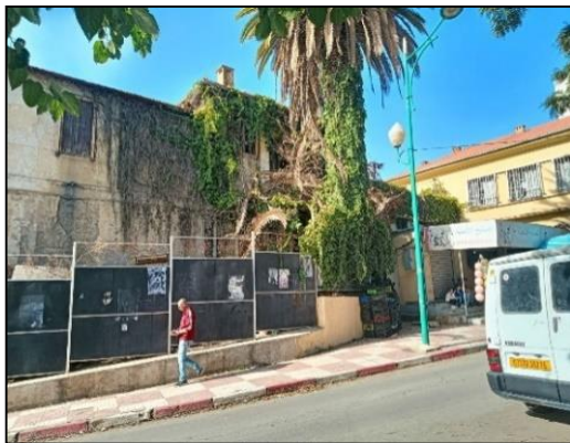
Figure 104: La vue sur la façade gauche de la rue Souibes Rabah, source: Auteurs, 2024
