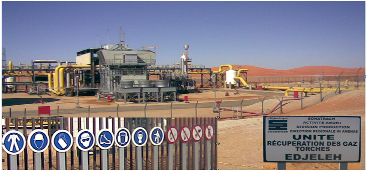
Figure .I.2. Vue générale de l'unité
