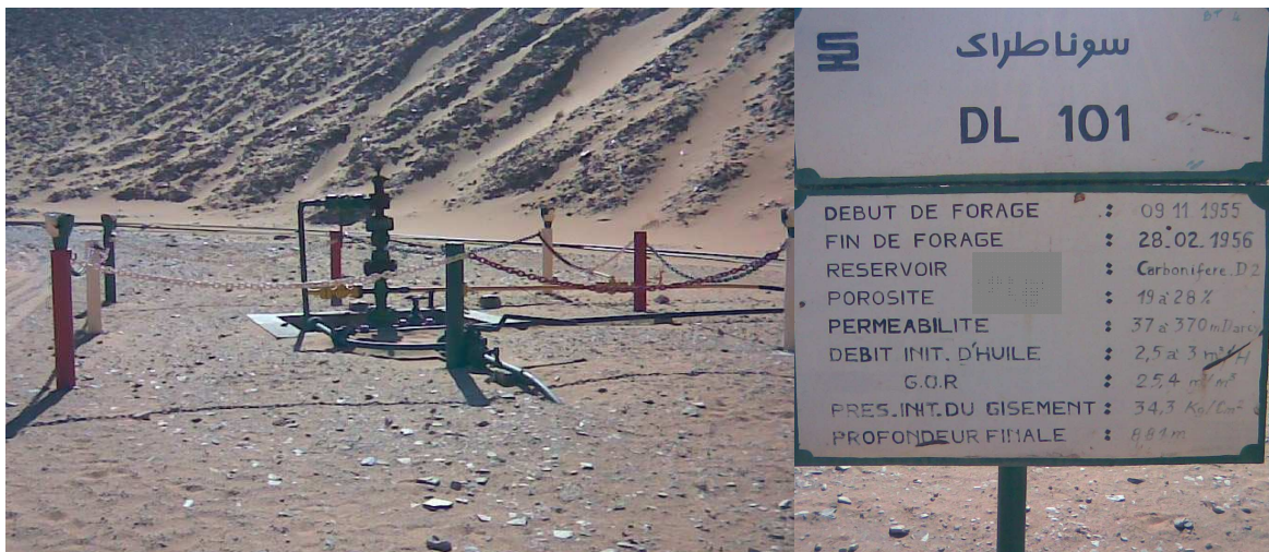
Figure. I.1. Photo du puits DL101.
