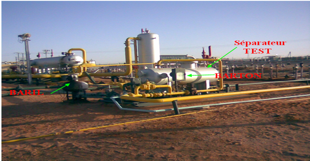
Figure. I.5. Vue de derrière d'un centre de séparation.
