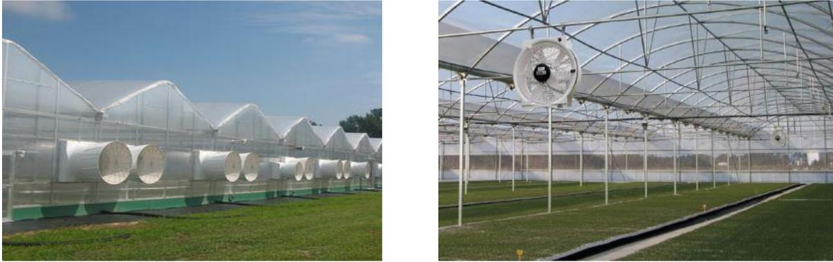
Figure (I.10) : aération dynamique des serres.
