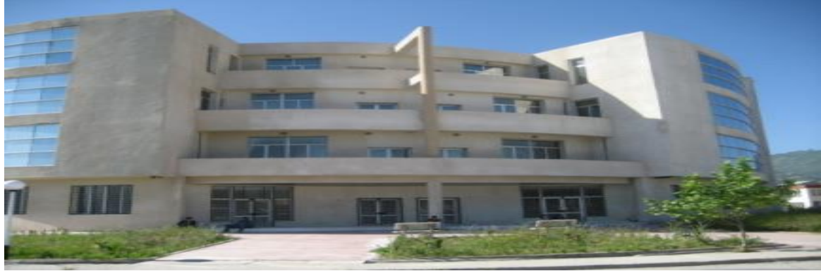
الشكل رقم 03: مبنى المكتبة المركزية
