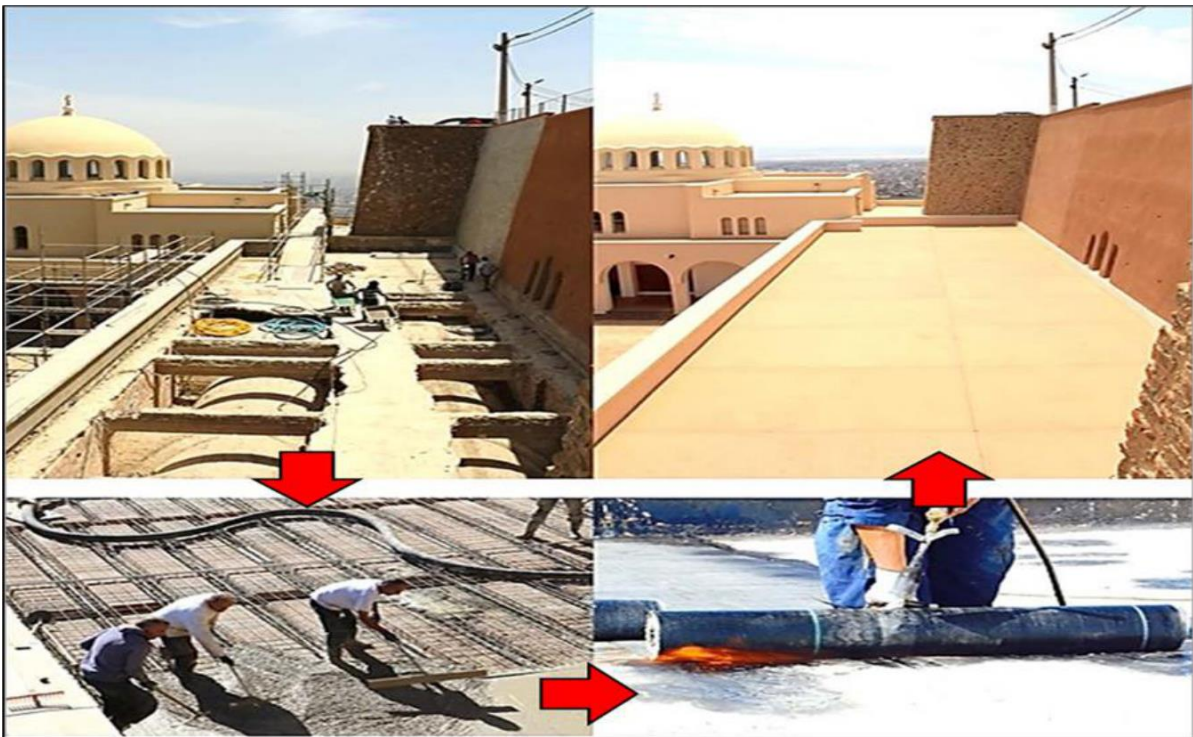
Fig 21 : Renforcement de la structure du Cloître
