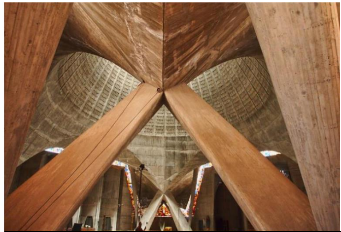
Fig 31 : Le croisement des structures à l'intérieur de l'église Source : https://structurae.net/fr/ouvrages/cathedrale-du-sacre-coeur-d-alger/photos
