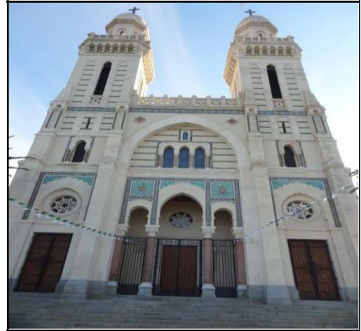
Fig 16 : Façade après restauration Source : http://www.petit-bulletin.fr/grenoble
