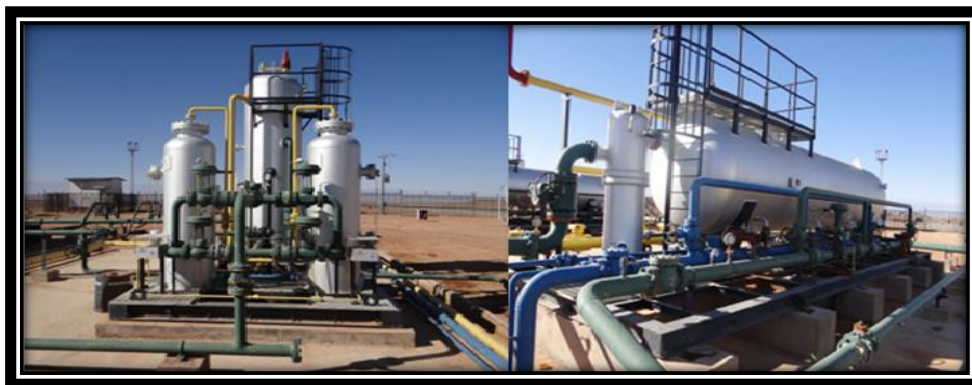
Figure 08 : Séparateur vertical (teste) et horizontal dans un CS.
