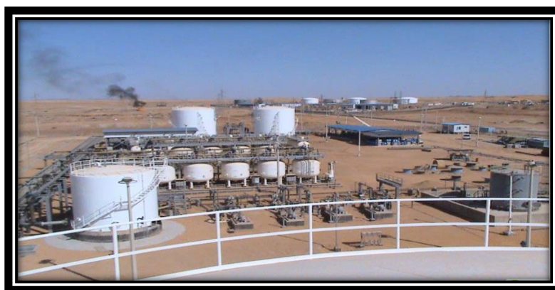
Figure 09 : Centre de Traitement d'Eau (CTE).
