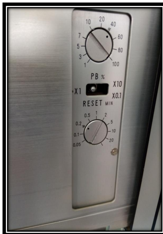
Figure 50 : Paramètres PID du régulateurs FIC332.
