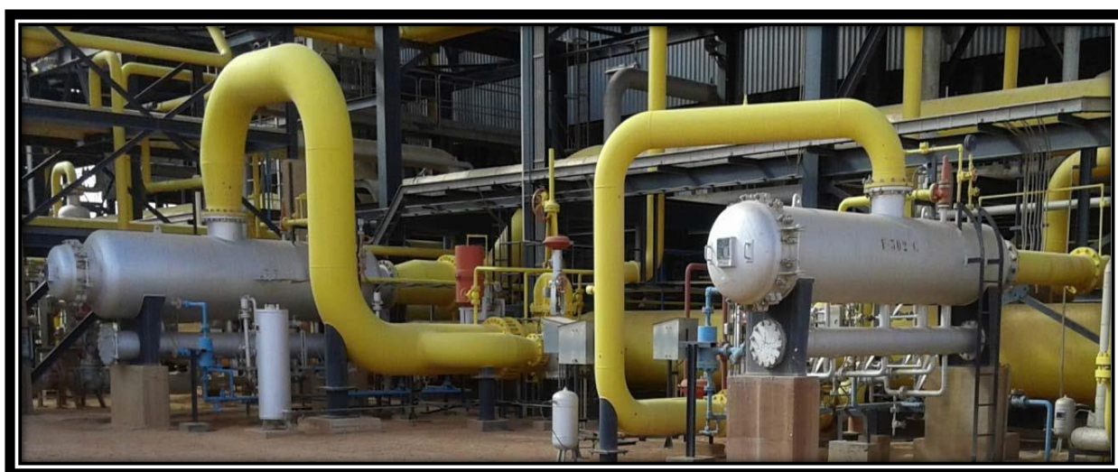
Figure 17 : Filtres F-301C et F302C.
