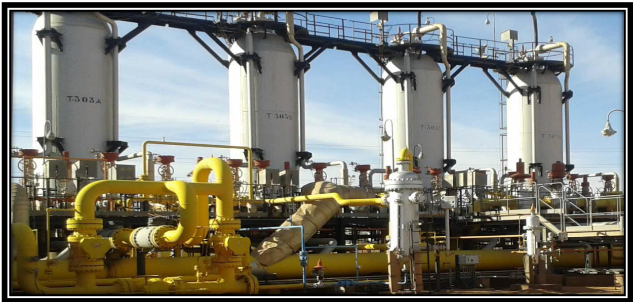
Figure 26 : Tours de déshydratation par adsorption T-303A, B, C et D.
