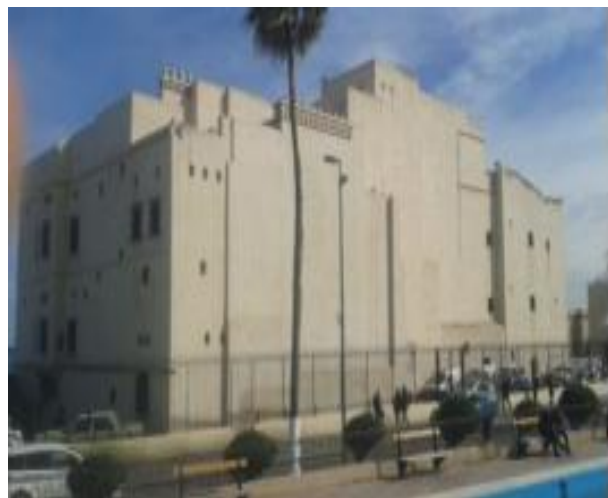
figIV-4 : Réhabilitation du Bastion 23 source :auteur
