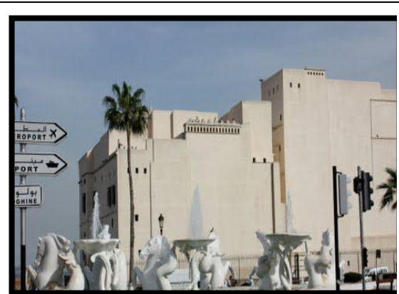
Le bastion 23est isolé de la ville
