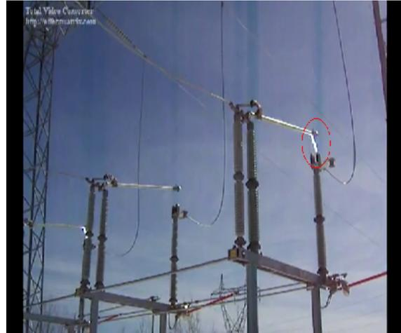
Figure(III.13) : amorçage d'arc électrique à l'ouverture d'un sectionneur.
