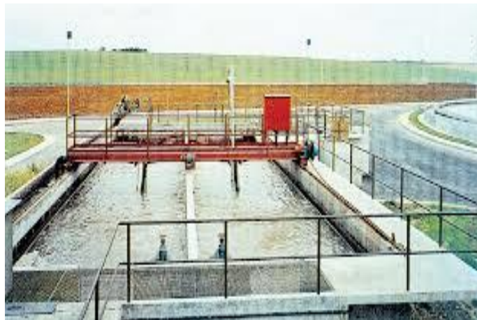
Figure III. 5 Ouvrage de dessablage.
