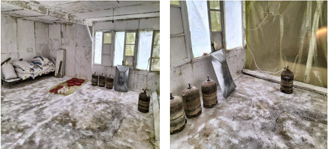
Figure 17 : Bâtiment caille vue de l'intérieur
