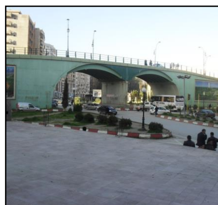
Carrefour de 20avril: Source : auteurs janvier 2016
