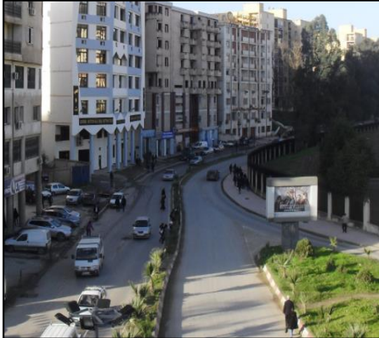
Fig.32. Etat actuel de boulevard frères Belhadj Source : Auteurs
