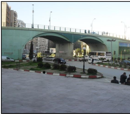
Fig. 53. Etat actuel de nœud 20 avril Source. Auteurs
