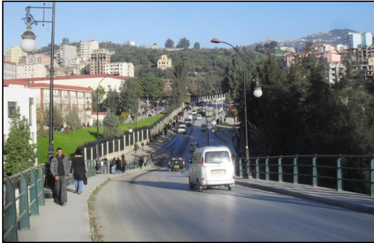
Fig.23. Etat actuel de la 1ère séquence de la voie des frères Ouamrane Source : Auteurs
