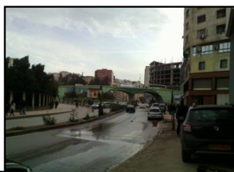
Carrefour de 20avril: Source : auteurs janvier 2016
