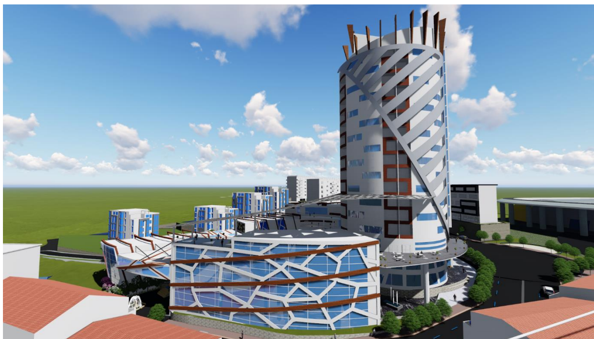
Façade donnant sur le nœud 1er novembre
