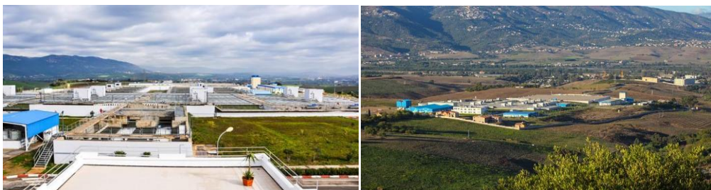
Figure 5 : Station de traitement seaal à tizi ouzou (Société des Eaux et de l'Assainissement d'Alger) (Messir.H 2019)
