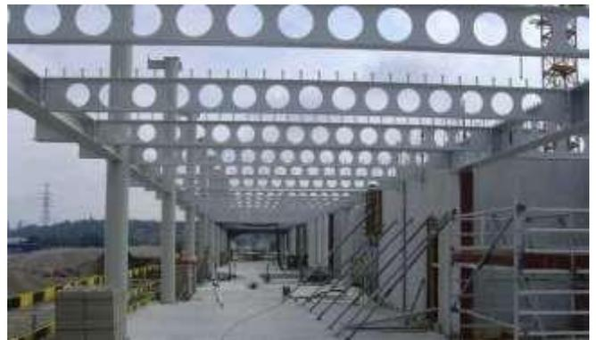
Figure 134: Les poutres alvéolaires
