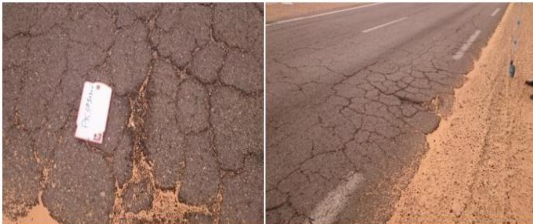
Figure 2.13. Faièncage à mailles fines
