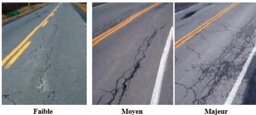
Figure 2.11. Fissurations longitudinales
