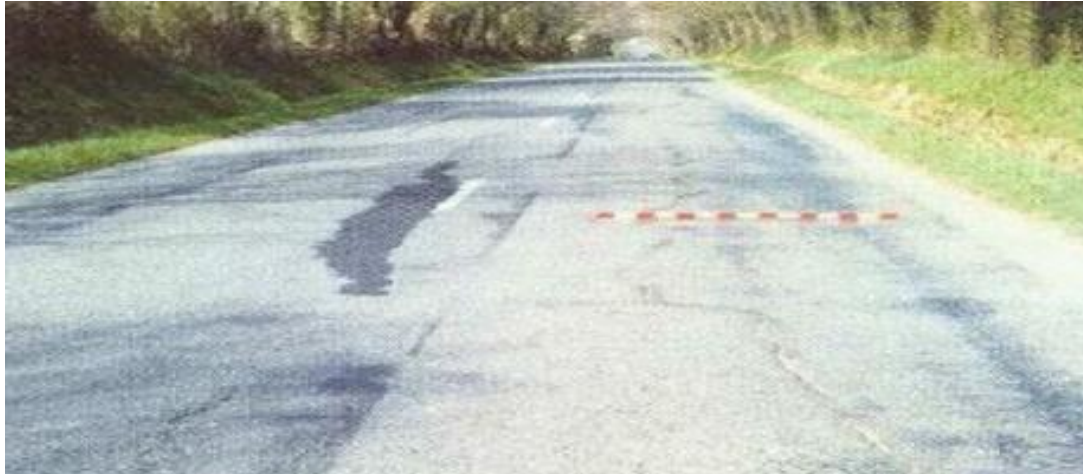
Figure 2.12. Fissure d'adaptation
