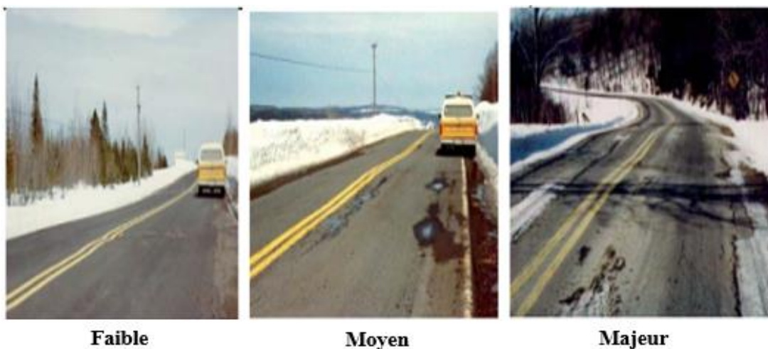
Figure 2.6. Soulèvement différentiel
