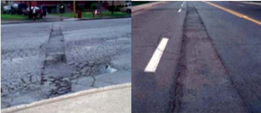
Figure 2.20. Coupe ou tranchée sur une chaussée
