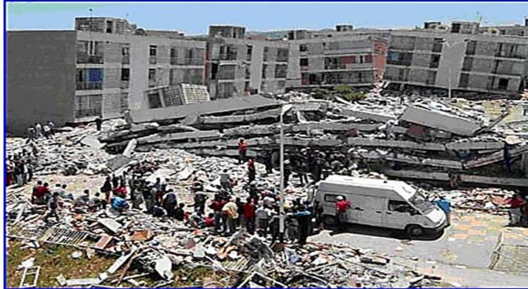
**Figure II-11** : Effondrement des constructions durant le séisme de Boumerdes 2003
