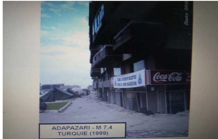
**Figure III-11** : Liquéfaction du sol séisme d'Adapazari en Turquie 1999
