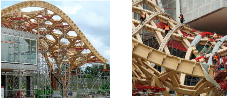
Figure 47 : Assemblage de la charpente en bois
