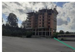
Immeuble en cour de construction R+5
