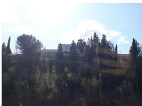
Station de météorologie R+2
