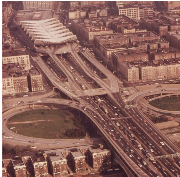
Figure : Photo réelle de la gare GWB
