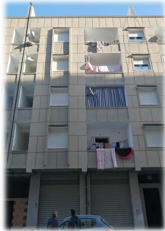
Figure II.13 : Vue sur la structure avoisinante de la structure inspectée.
