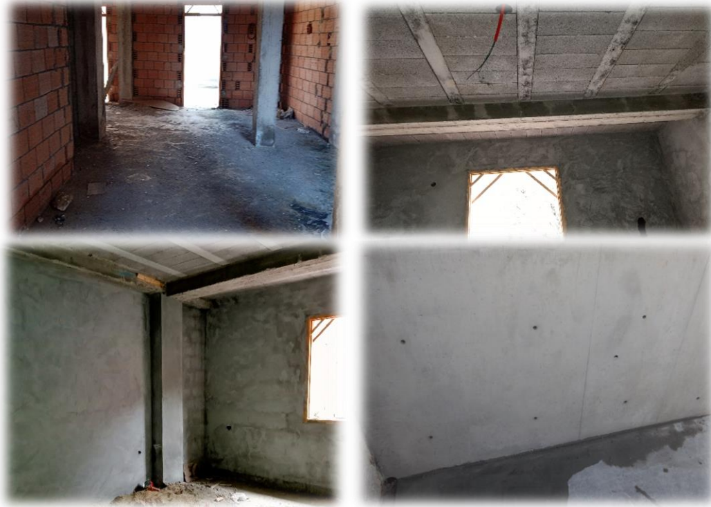
Figure II.9 : Elément poteau, voile et poutre.
