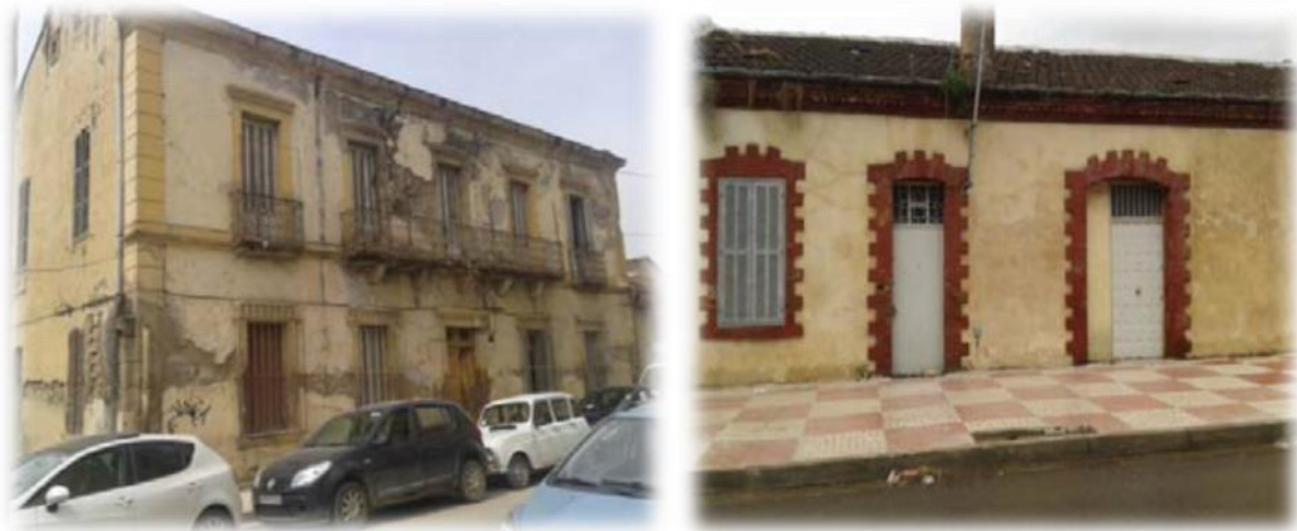
Figure II.3 : Vue de structures en maçonnerie (Cherifi, 2016).
