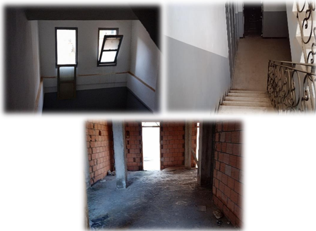
Figure.II.12 : Eléments en maçonnerie.
