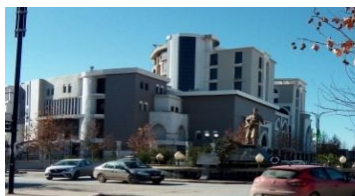
Figure 45 _Palais du Justice Source : Auteur.
