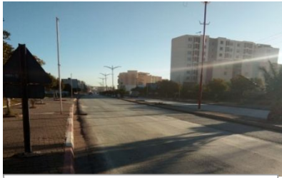
Figure 113 : le boulevard zighoud youcef avant l'intervention. Source : Auteur.
