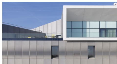
Figure 148: Utilisation des feuilles métalliques. Source : https://divisare.com/projects/267280-brenacgonzalez-sergio-grazia-mediathèque-choisy-le-roi
