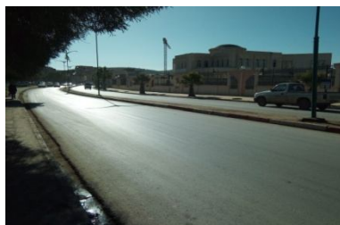
Figure 121 La rue Mohamed Talbi Salah avant l'intervention Source : auteur
