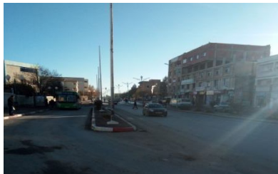
Figure 21 : le boulevard zighoud youcef avant l'intervention. Source : Auteur.
