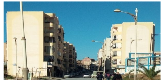
Figure91_ Image qui présente les parois de la rue qui définit l'entité 1 et2.
