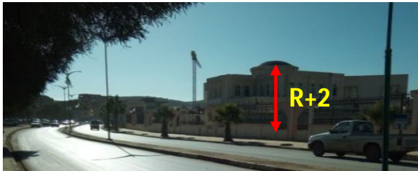
Figure 17 - les deux parois de la rue Talbi Mohamed Salah. Source: Auteur.
