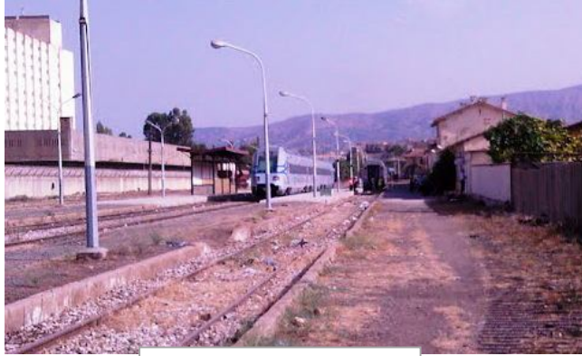
Figure 25– La voie ferrée Source : Auteur.
