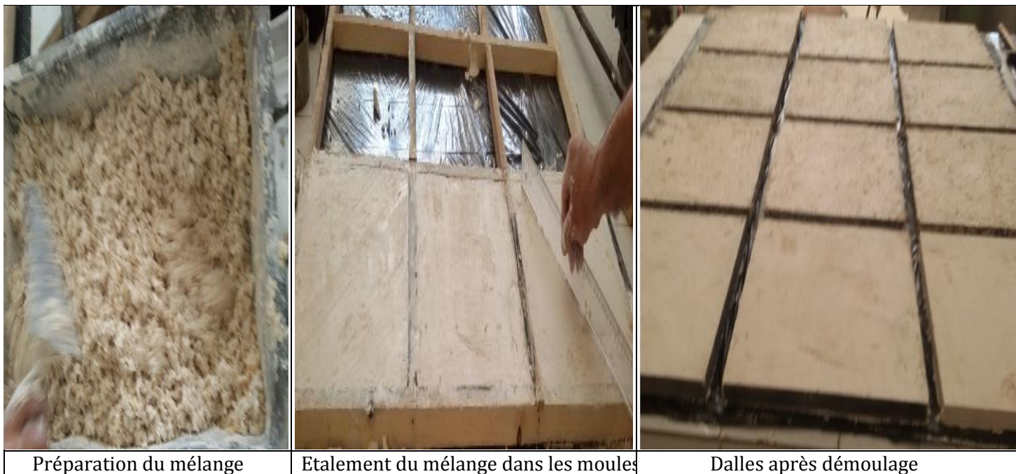
Figure III.17 : Principales étapes de réalisation
