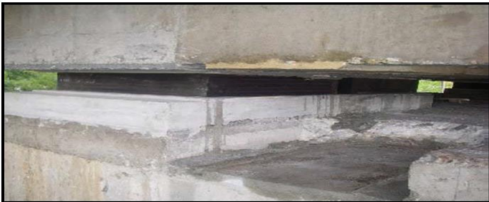
Figure XI-1: Appareil d'appui en élastomère fretté.
