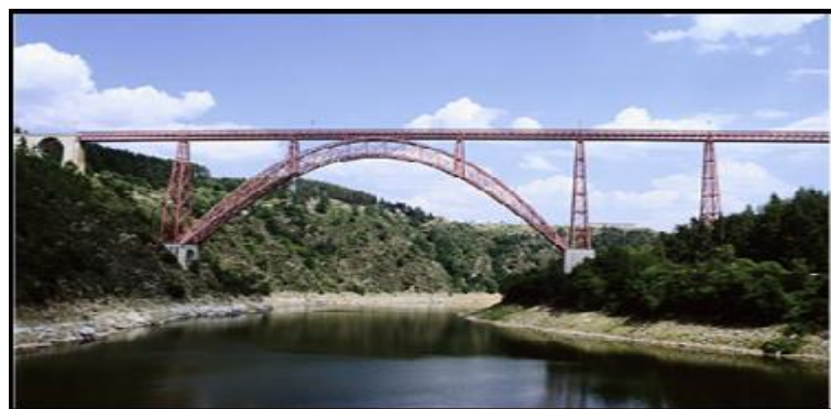
Fig. 5 : Pont arc en acier « viaduc de Garabit » construit en 1884[Réf.1].
