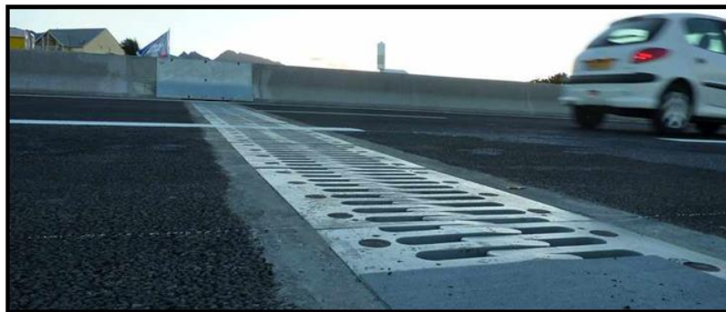
Figure XI-8 : Photo réelle d'un joint de chaussée
