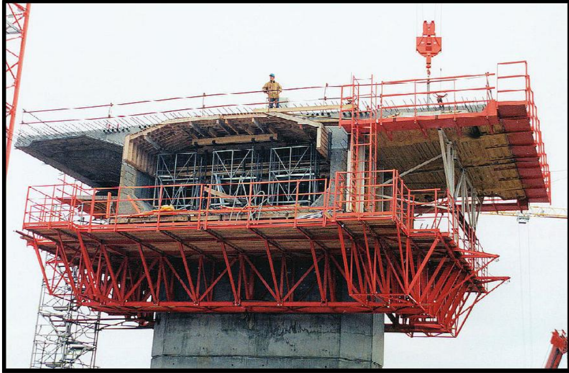
Fig. II. 9. Réalisation d'un voussoir sur pile.
