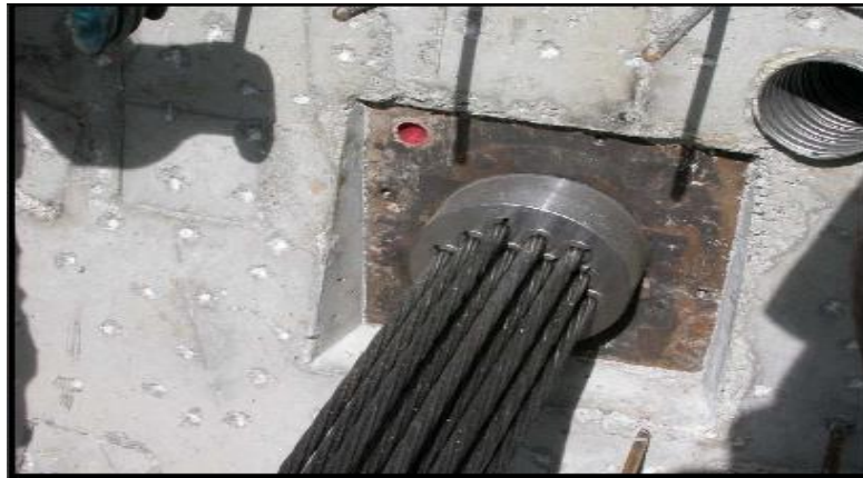
Fig. III.3 : Acier actif (12T15S) [Réf.15].
