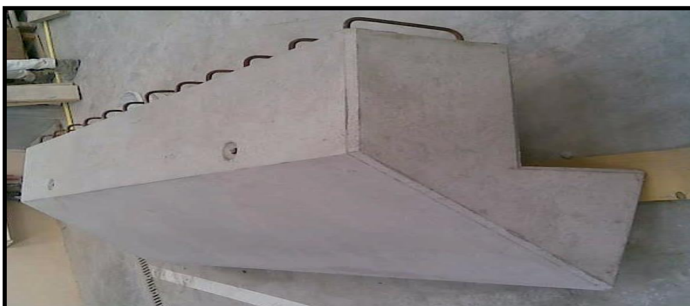
Figure XI-13 : photo Corniches préfabriquées sur chantier.
