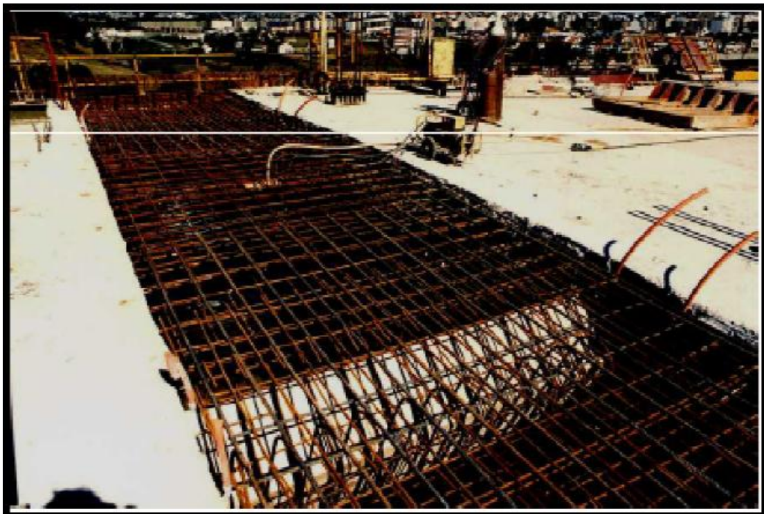
Fig. II. 11. Ferrailage du voussoir de Clavage (France).
