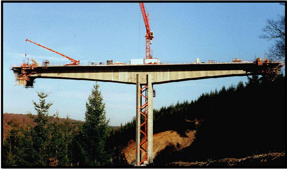
Fig. II. 10. Réalisation d'un fléau (France).
