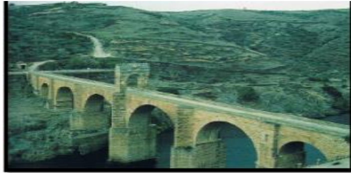
Fig. 4 : Puent Alcantara sur le Tage (98 apr. J. C) [Réf.1].
