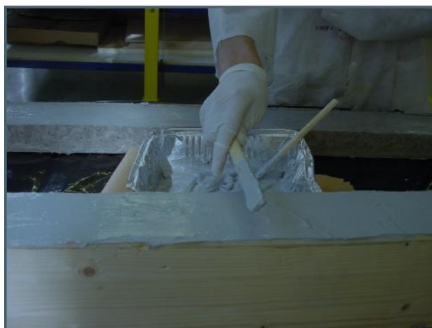
Fig II-2 : Connexion par collage
