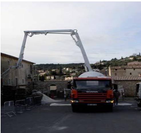
7- Le plancher est prêt à recevoir le coulage du béton.
