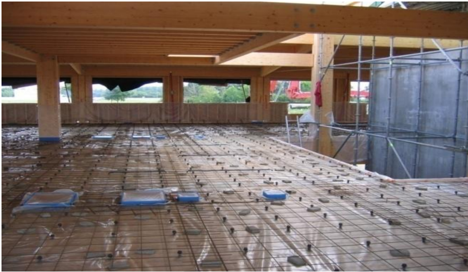
Fig I-5 : Structure à plancher mixte [5]
