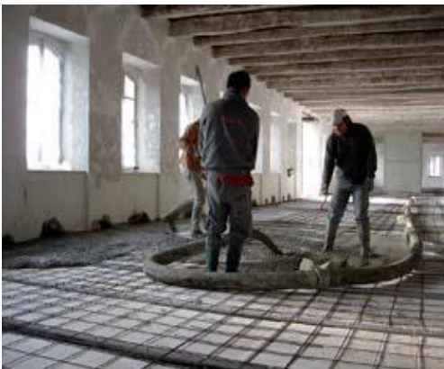
9- Mise en action de la pompe à béton.
