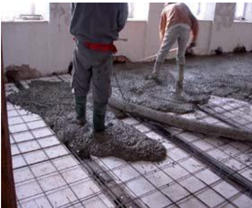
10- Compagnons en train de « tirer » le béton.
