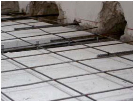
5- Les renforts sont ensuite positionnés.
