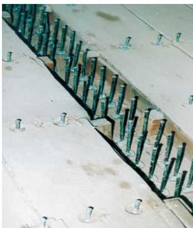
Fig II-11: Mise en œuvre en réhabilitation (connecteur en contact direct avec la poutre principale et sur les solives secondaires)
