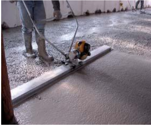
11- Lissage de la dalle.
