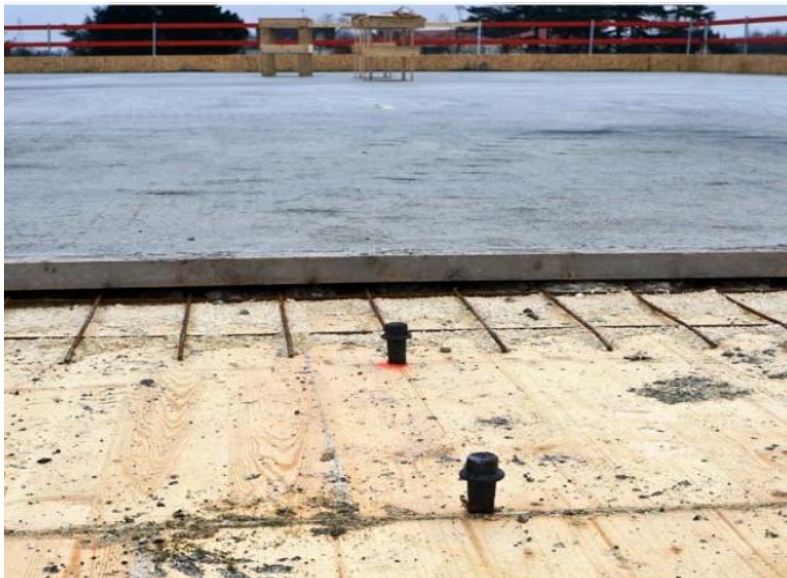
Fig I-1: Planchers mixte bois /béton [2].
