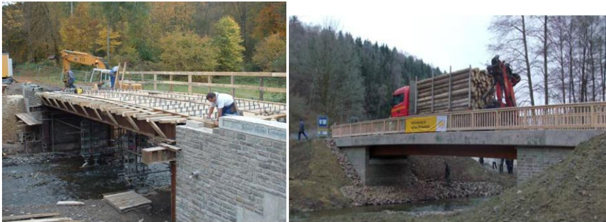
Fig II-28: Le pont en phase de réalisation ainsi que à la fin des travaux
