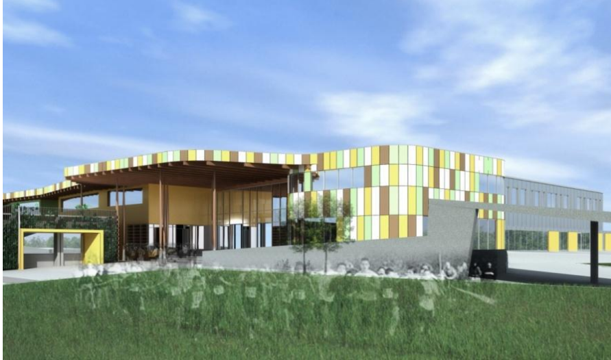
Fig I-6 : Collège CALIPSO à Montreuil-Bellay –Vue de l’entrée (structure mixte bois-béton) [5].
