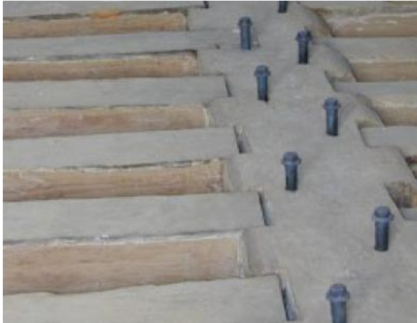
Fig II-9 : Vue d'une mise en œuvre des connecteurs SBB → vue en coupe
