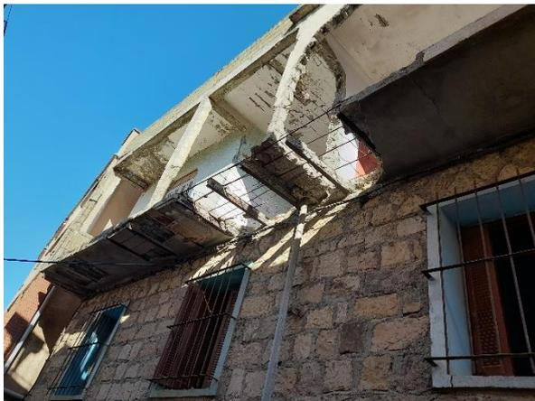
**Figure 11 :** Fissuration des maisons à cause des glissements de terres. **Source :** Auteurs. Photo prise à Sahel le 18-01-2022.
