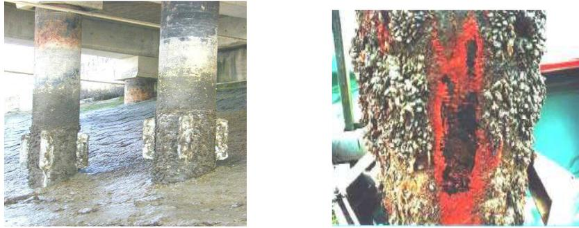
**Figure I.4: Pathologie des pieux due à l'attaque sulfatique (eaux agressives) [10]**
