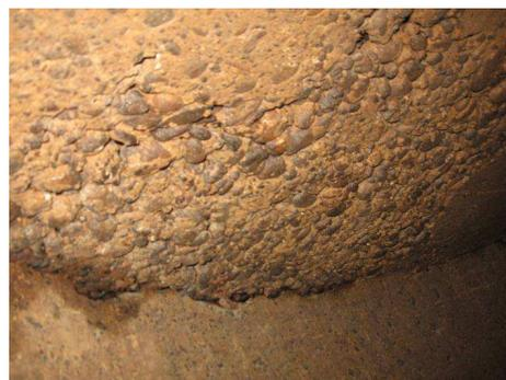
**Figure I.5: Lixiviation du béton**
