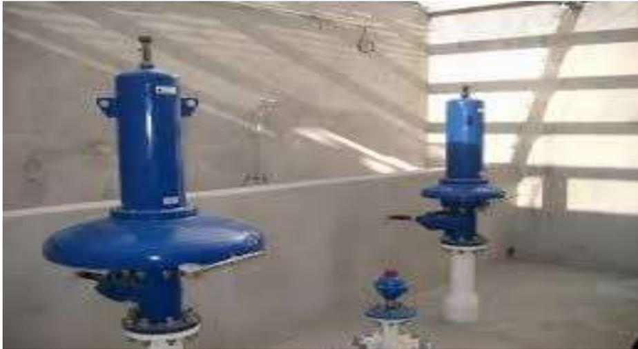
*Figure (VI-5) : soupape de décharge*
