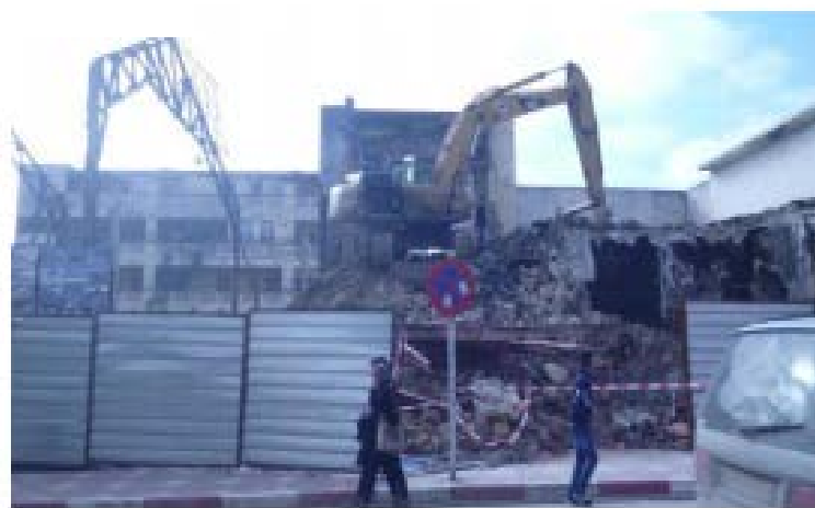
Figure 75 Démolition du cinéma Djurdjura de Tizi-Ouzou Source : Mémoire de Magister- Les salles de cinéma de la période coloniale , Mme MEZEGHRANE- Z ép. KLARI
