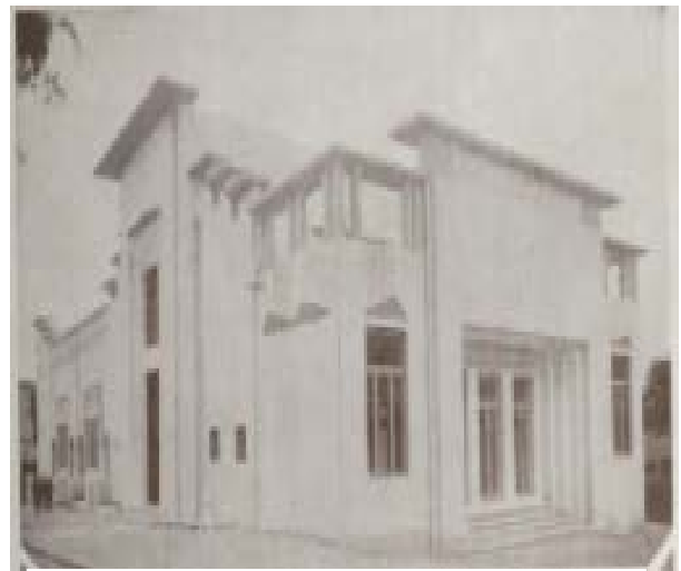
Figure 74 vue extérieur de la salle Source :Auteurs
