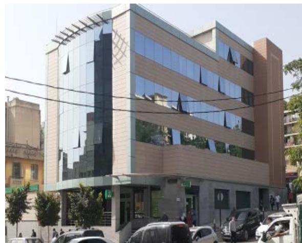
Figure 44 banque BNA Source : Auteurs
