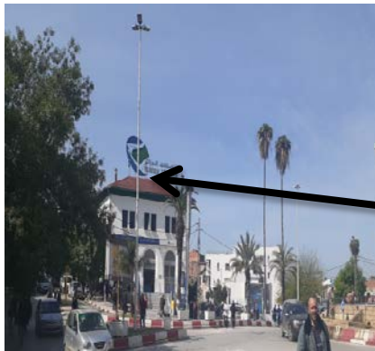
Figure 40Algerie telecom de t-o Source :auteurs
