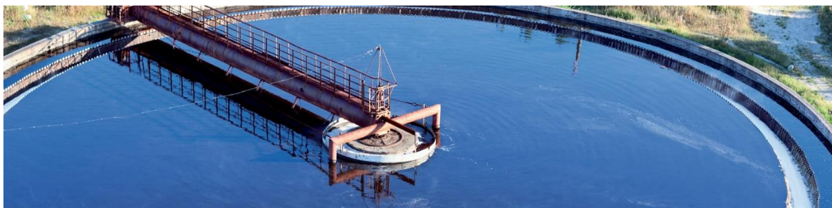
Figure (I - 23) : Générateur d'oxygène pour traitement des eaux usées.
